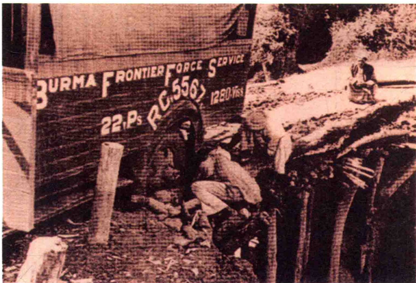
山崩路塌，坡陡弯急，事故频频发生
